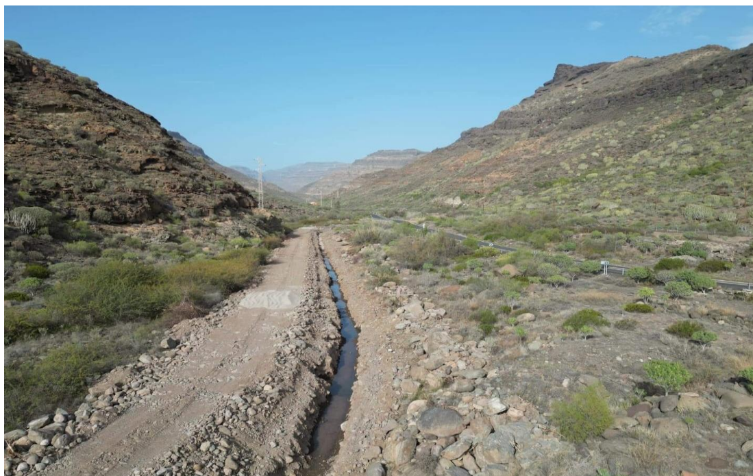
Ilustración 6 Trabajos para tubería de impulsión de agua desalada. Fotografía de OVD.
