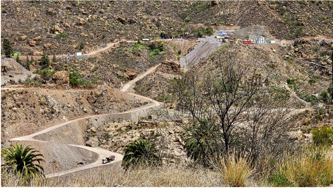
Ilustración 7 Creación de accesos y modificación de los existentes. Fotografía de OVD.
