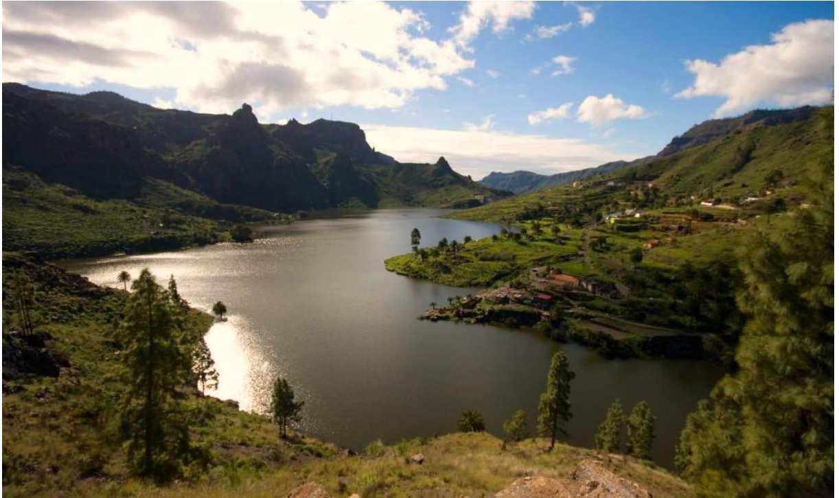
Ilustración 10 Presa de Chira. Fotografía de OVD,
