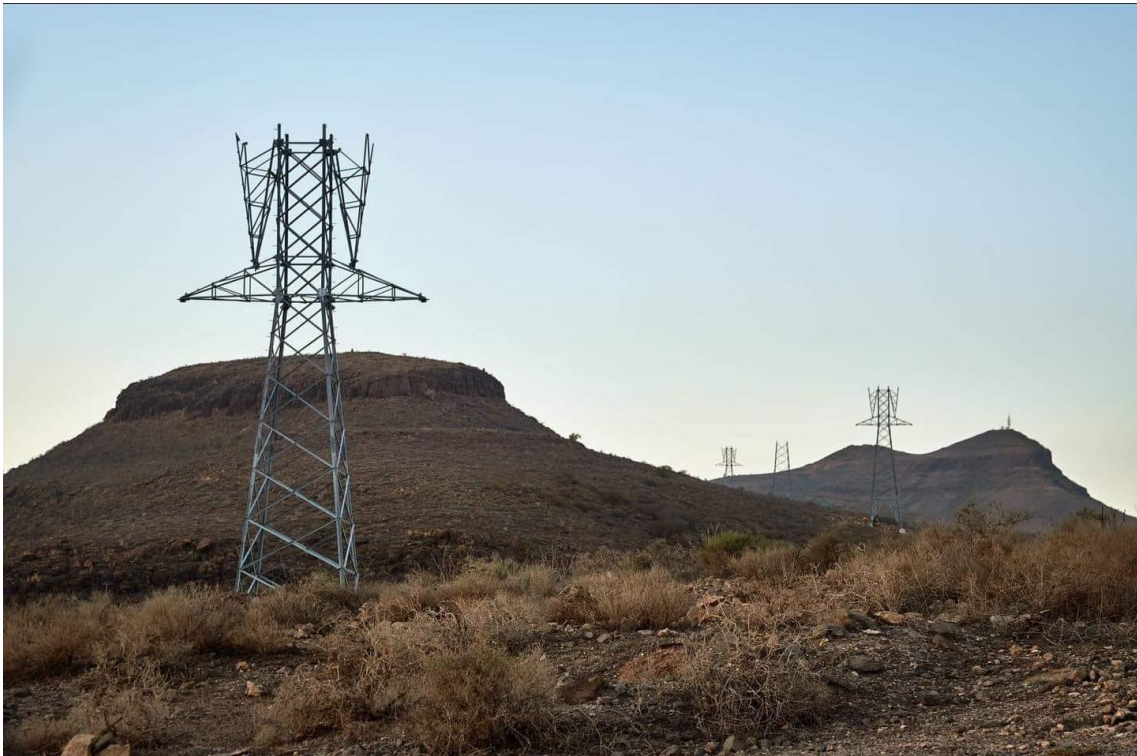
Ilustración 5 Trazado de la línea de alta tensión Fotografía de OVD.
