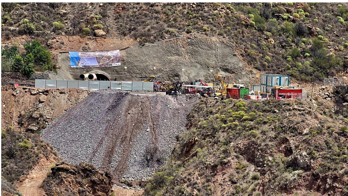
Ilustración 3 Parte de materiales Inertes producto de la excavación. Fotografía de OVD
